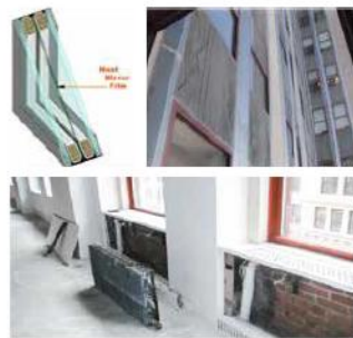
图二：外部结构节能化改造
